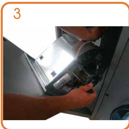
Svitare e rimuovere il pannello frontale con il ventilatore / Unscrew and remove the frontal panel with the fan
