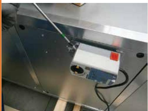
Azionare il pulsante di sblocco e portare fine corsa verso l'alto, in questo modo il cavo bianco andrà a chiudere il by-pass mentre il cavo nero lo andrà ad aprire. Aprire successivamente il pannello superiore e controllare che tutto funzioni correttamente. Operate the release button and bring the end of upward stroke, in this way the white wire will go to close the by-pass while the black wire going to open it. Then open the top panel and control everything is working properly.
