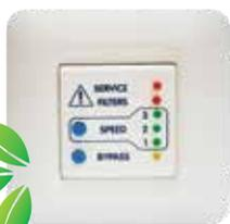
Pannello di controllo con pulsanti di comando e led di segnalazione, remotabile con cavo di lunghezza fino a 50 mt (a carico del cliente)
