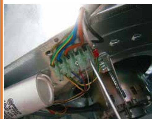
Après avoir retiré l'alimentation ou sectionné la machine, débrancher les fils du ventilateur
