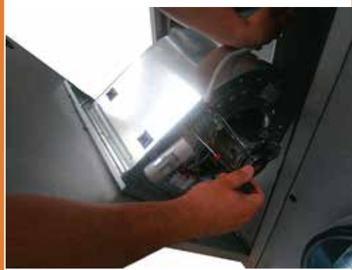
Dévisser et retirer le panneau frontal avec le ventilateur
