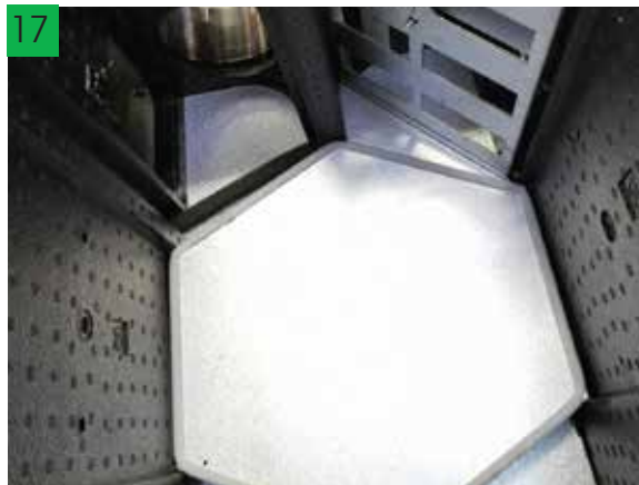
17 Posizionare la lamiera dietro il pacco di scambio | Position the sheet behind the heat exchanger
